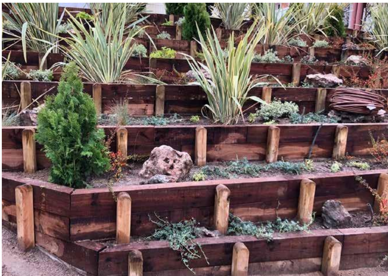
Aplicación traviesa en talud
